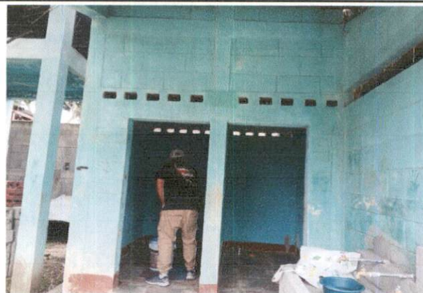
Foto 2: Instalación de dos Sanitarios y piso cerámico antideslizante.
