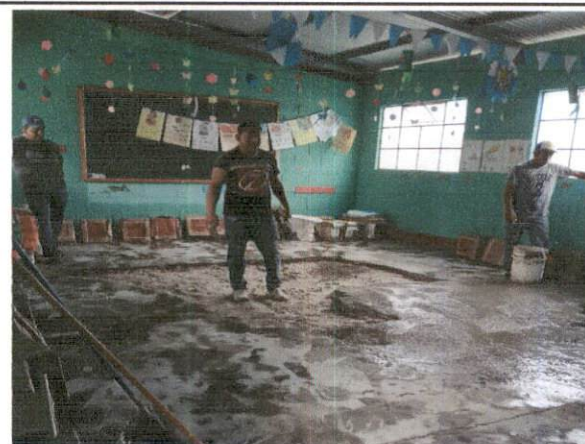
Foto 4: Reparación e instalación de piso cerámico en dos aulas, pintura de las aulas.
