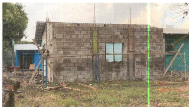
Foto 1: Reparación de cocina y construcción con su galera.
