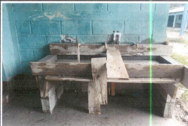
Foto 3: Instalación de una pileta con sus 3 chorros.
